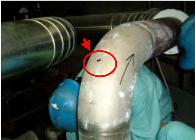
配管口径：150A（外径 約170mm） 配管材質：ステンレス鋼（SUS304L）
