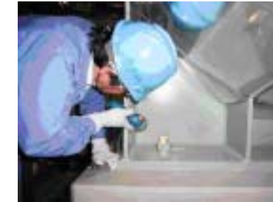
配管支持構造物の目視・打診点検状況
