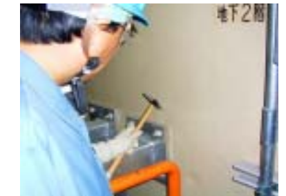
配管支持構造物の目視・打診点検状況
