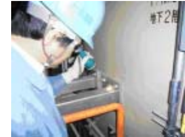
配管支持構造物の目視・打診点検状況
