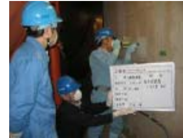
コンクリート強度測定状況
