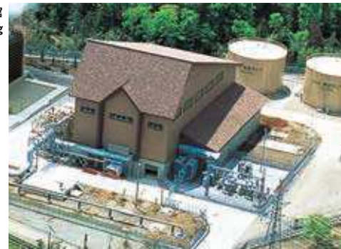
発電所本館 Main building
