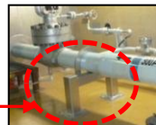
部材追加 補強工事の例
