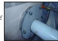
貫通部シール施工例
