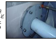
貫通部シール施工例
