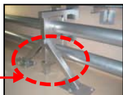
補強工事の例
