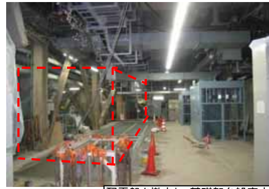
【配電盤を撤去し、基礎架台設定中】
