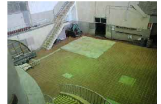
【現在の復旧状況】
