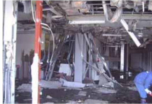
【4号機タービン建屋1階入口】
