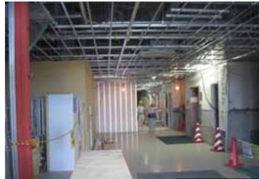
【壁・天井を復旧中】
