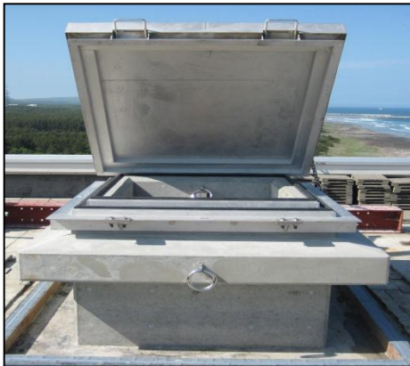
<設置状況写真>
