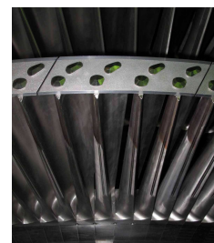
矢視A：磨耗① 取替後
