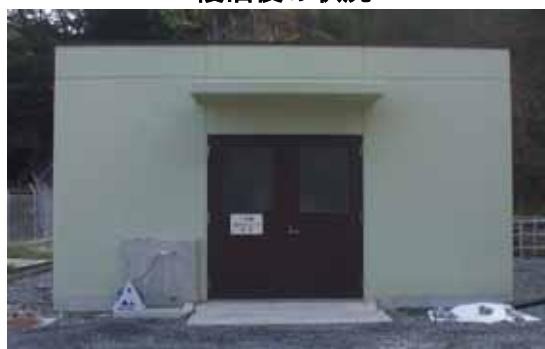
復旧後の状況
