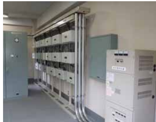
海水温度モニタリング装置 （データ伝送装置）復旧状況
