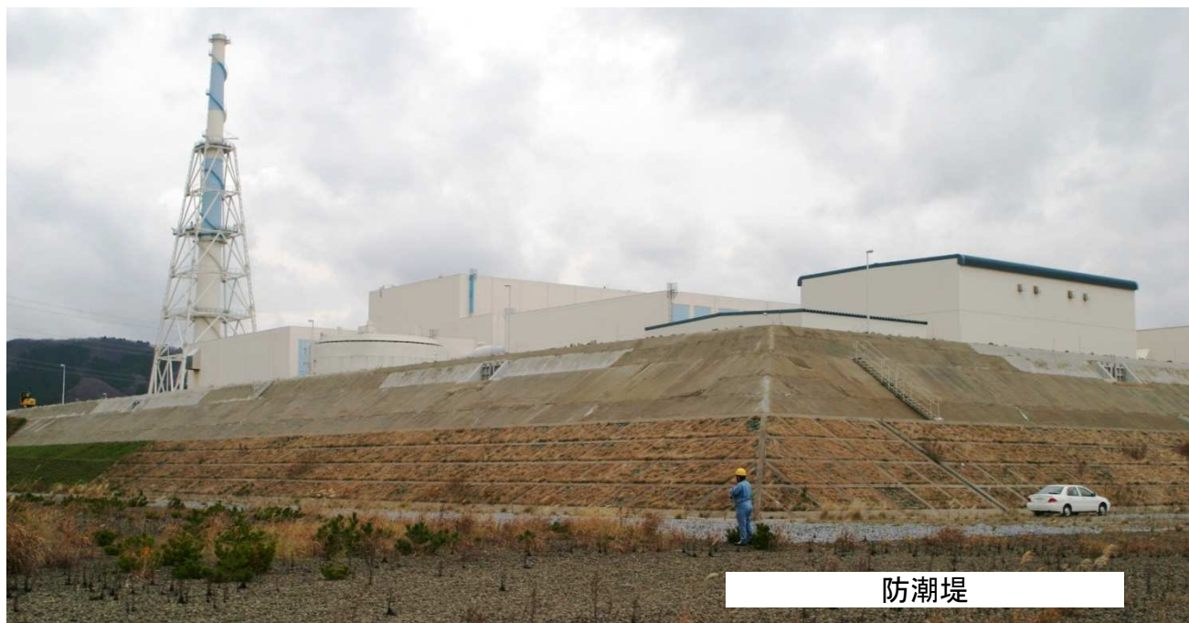
防潮堤 (高さ約2mまで完了)
