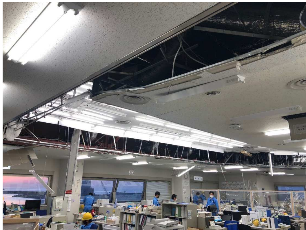
事務本館5階 執務室
