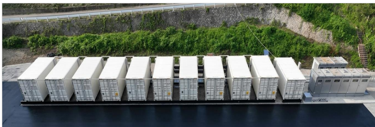
宮城 AI データセンター（外観・上空）
