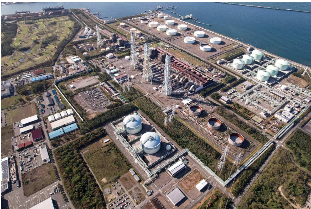
(参考) 東新潟火力発電所全景写真
