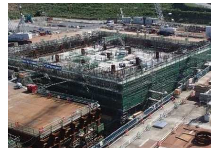
緊急時対策所 （女川：建屋躯体工事）
