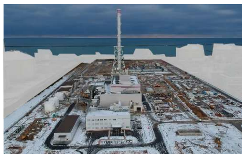
上越火力1号建設状況 （2022年1月現在）
