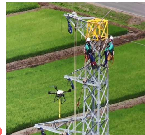
ドローンによる延線作業の様子 （2021年8月）
