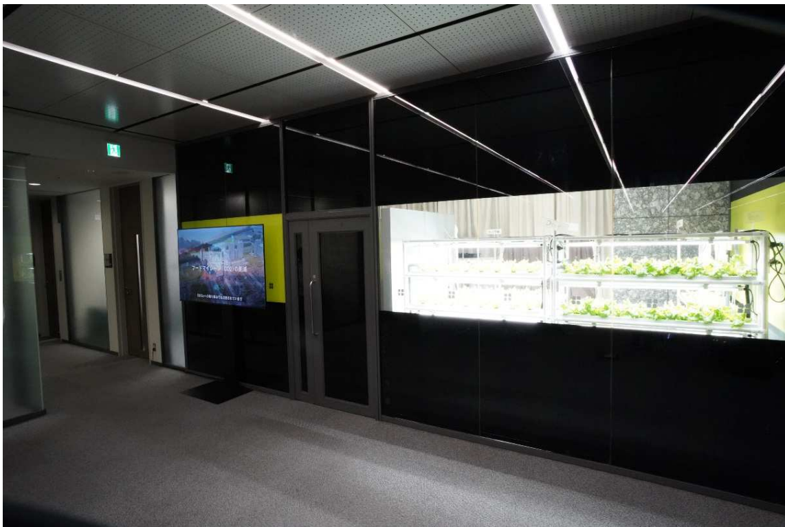
本店ビル2階 実証試験スペース
