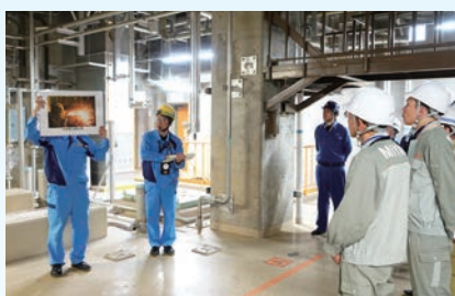
現場調査の様子
