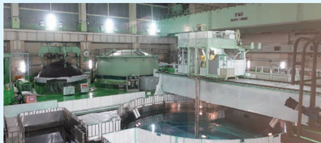
燃料交換機を使用した燃料集合体の取替え （560体中80体を新燃料に取替え）
