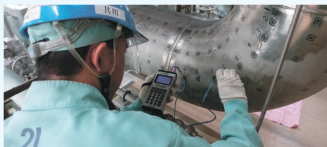
超音波厚さ測定器による配管の肉厚測定 （配管約170箇所を検査）
