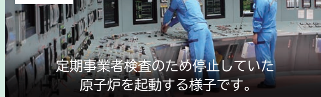
外部電源が失われたと想定し、非常用の発電機を正常に起動させる検査です。
