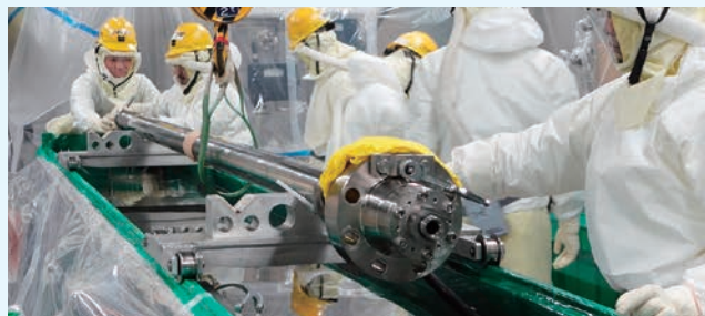
制御棒駆動機構の分解点検 （137本中20本を取り外し、14本を分解点検し、残り6本を予備品と取替え）
