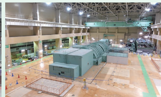
原子炉で発生した蒸気を受けて稼働するタービンと発電機
