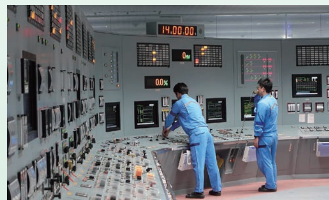
中央制御室でスイッチを操作し原子炉を起動
