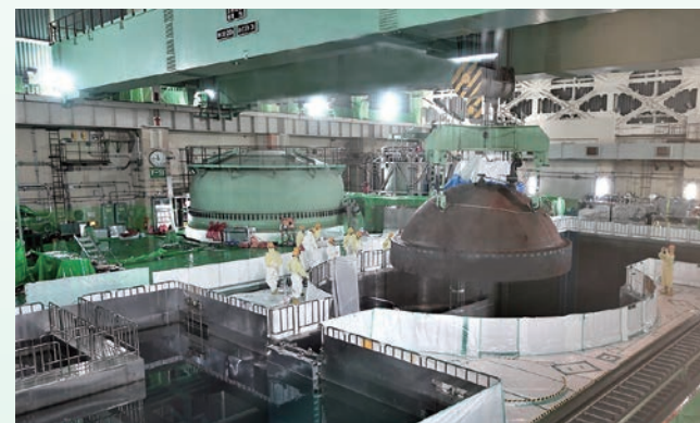
「原子炉」の蓋を吊り上げて移動し、取り付ける作業
