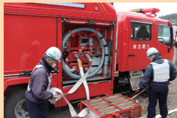
原水槽から給水するための消防車に、ホースをつなぎます
