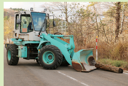
アクセスルートを確保するため、倒木をホイールローダーで撤去
