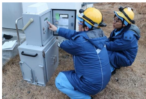
手順書を確認しながら、放射線量を図る装置を設置
