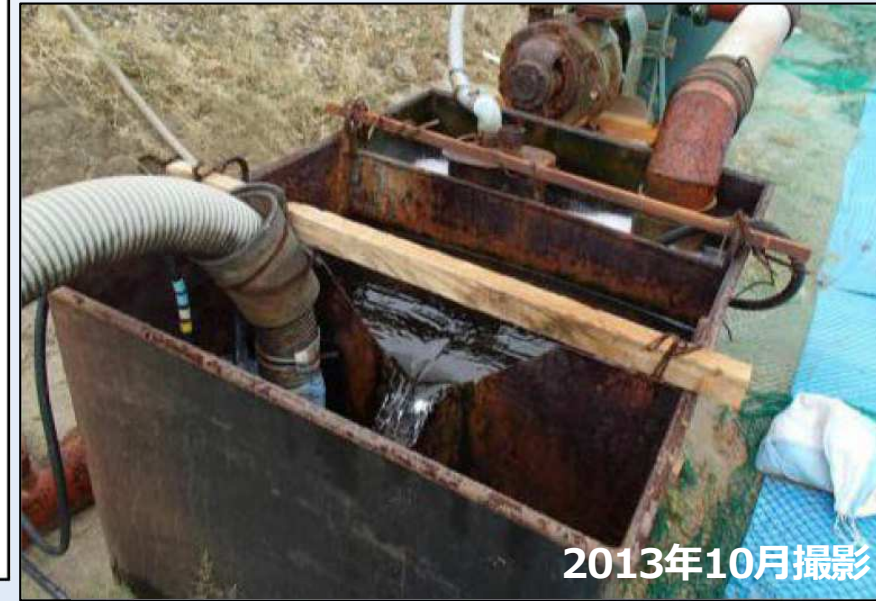
排水ポンプ (新仙台火力リプレース工事における事例)
