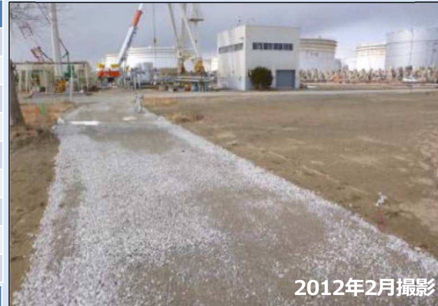
工事廃棄物の有効利用 (新仙台火力リプレース工事における事例)
