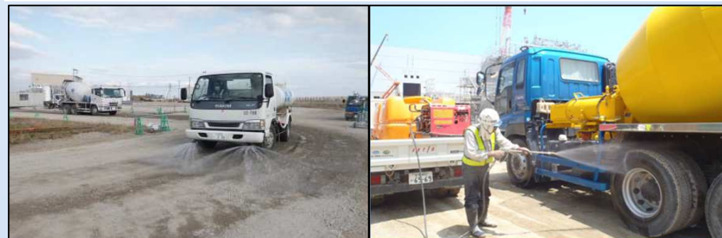
構内散水やタイヤ洗浄 (新仙台火力リプレース工事における事例)
