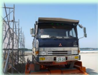
タイヤ洗浄及び構内散水の実施状況（新仙台火力リプレース工事）
