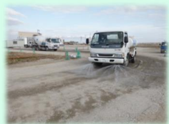
タイヤ洗浄及び構内散水の実施状況（新仙台火力リプレース工事）
