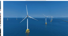
石狩湾新港洋上風力発電事業 (写真提供: JERA)
