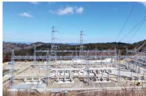
宮城丸森開閉所 (50万ボルト) 新設工事の設置状況
