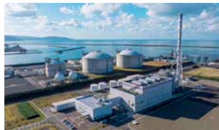
上越火力発電所第1号機
