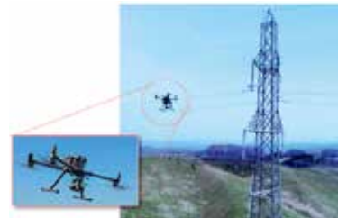
ドローン活用による設備点検の例 (電線劣化状況の確認)
