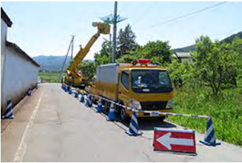
工事範囲のバリケード設置
