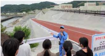
発電所施設見学会
