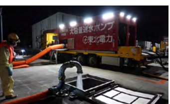
安全対策設備等を用いた対応が想定時間内に完了できることを確認するシーケンス訓練
