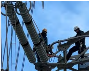
工事会社合同訓練 (施工検査研修)
