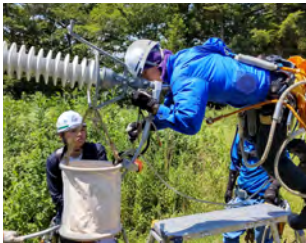
工事会社合同訓練 (実技研修)
