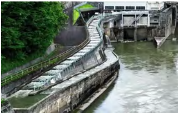
魚道（上郷発電所）
