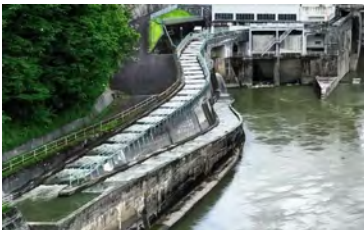
魚道（上郷発電所）
