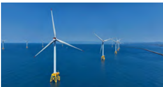
石狩湾新港洋上風力（提供：株式会社JERA）
