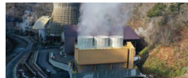
リプレース工事が完了した松川地熱発電所
