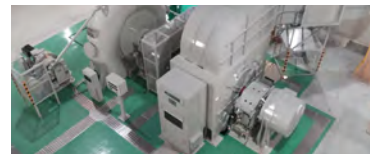
リパワリング工事が完了した木戸川第一発電所
