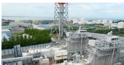
新潟火力発電所5号系列全景
