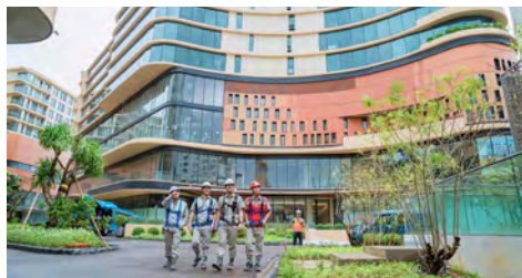
ティエンボープラザ （ベトナムにてユアテックグループが電気設備工事を実施）
