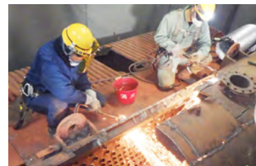
補助ボイラーの解体
