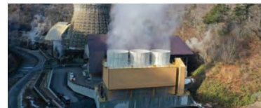
リプレイス工事が完了した松川地熱発電所
