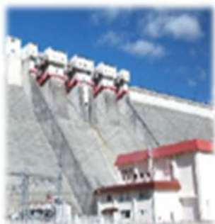
秋田県営水力発電所
