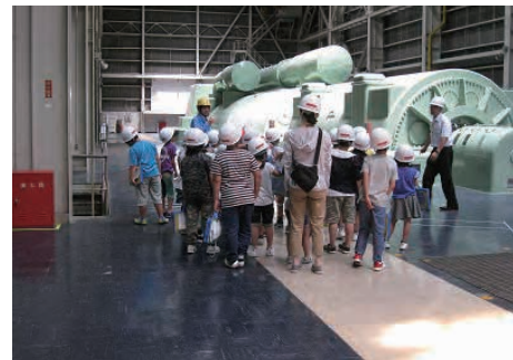
新潟火力発電所見学の様子／新潟支店
