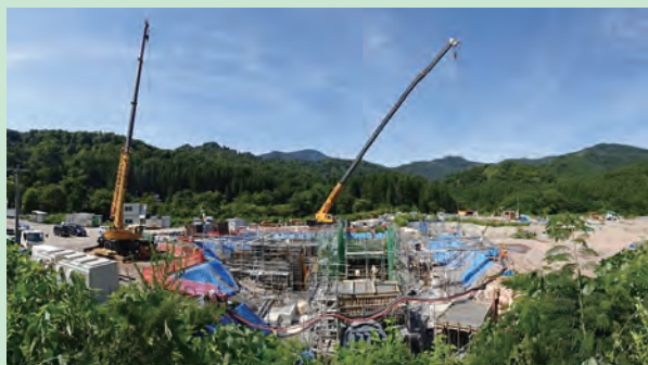
玉川第二発電所建設の様子
