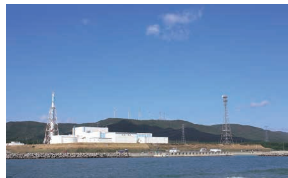
東通原子力発電所（青森県東通村）
