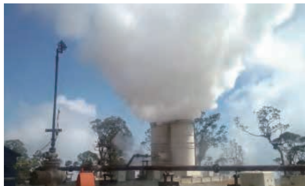
蒸気の噴気試験の様子
