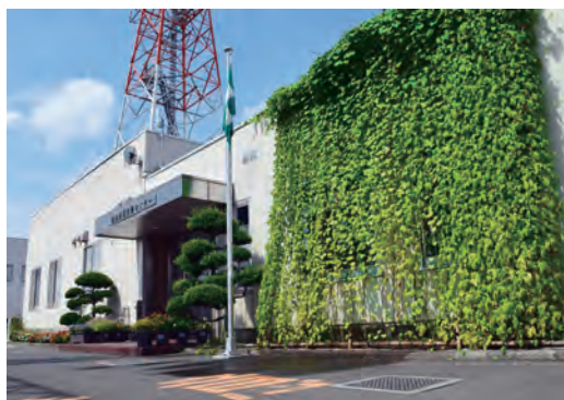
事務所ビルの緑のカーテン／福島発電技術センター
