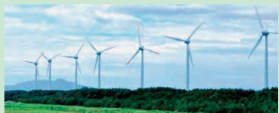
能代風力発電所
