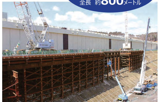
防潮堤の工事を実施している女川原子力発電所
