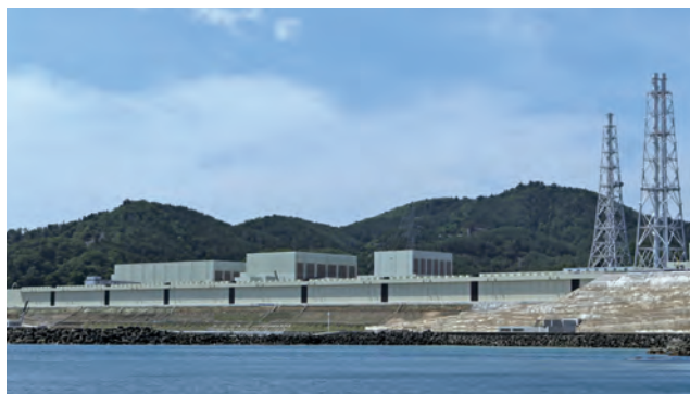
海拔29m、全長約800mにもおよぶ防潮堤の設置工事を実施している女川原子力発電所 (2017年6月撮影)
