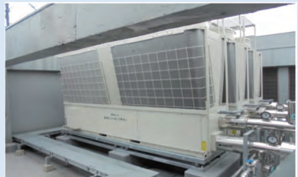
大町電力ビル本館屋上空冷ヒートポンプチラー設置
