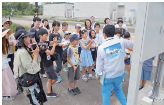
仙台太陽光発電所を見学する参加者
