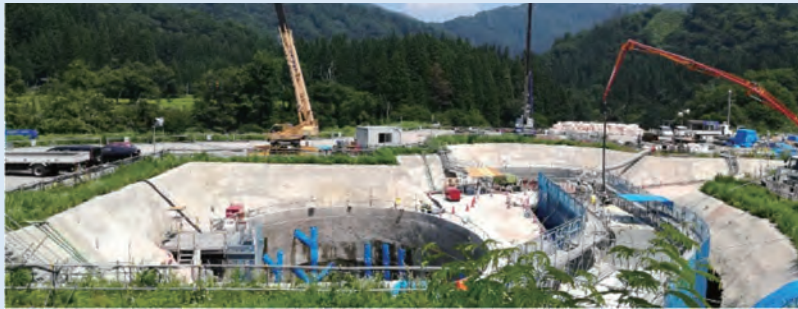
玉川第二発電所建設の様子
