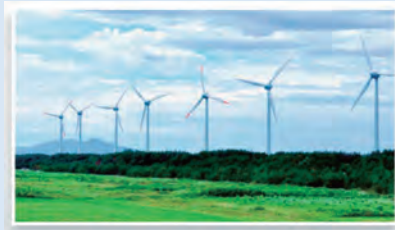
能代風力発電所
