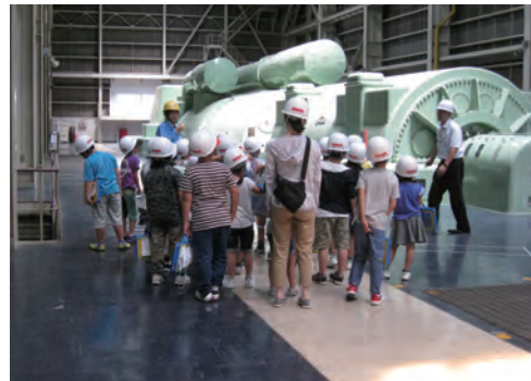
新潟火力発電所見学の様子／新潟営業所
