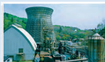
松川地熱発電所
