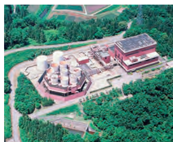
柳津西山地熱発電所 (福島県柳津町)
