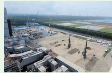
能代火力発電所3号機建設工事状況 (発電機本館基礎他工事)
