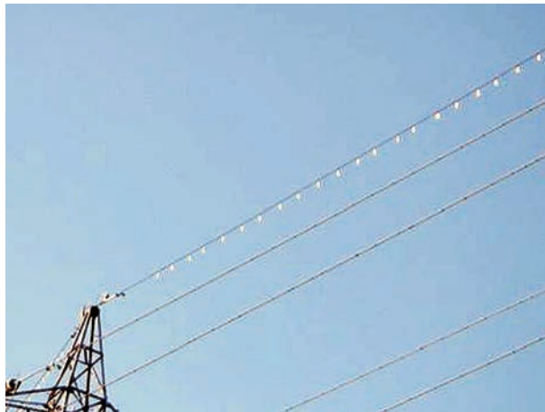
送電線への標識設置状況
