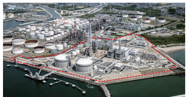
新仙台火力発電所3号系列
