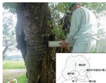
精密診断機器による調査状況 (幹断面の腐朽の有無を確認します)
