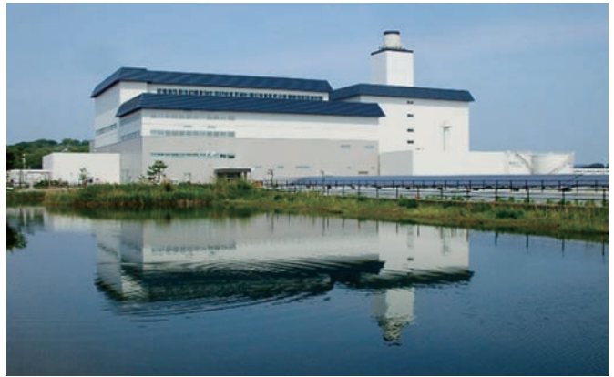
仙台火力発電所4号機(宮城県七ヶ浜町)
