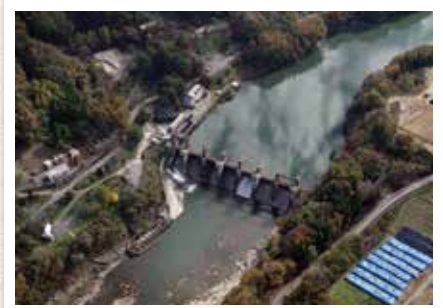
2014年6月に営業運転を開始した飯野発電所 (福島県福島市)
