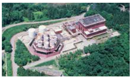
単機として国内最大出力を誇る柳津西山地熱発電所(出力6万5,000kW/福島県柳津町)
