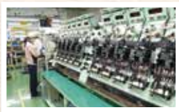
電力量計の修理・点検
