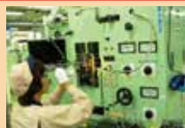
電力量計の修理・点検
