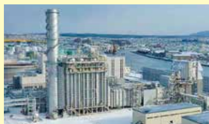
コンバインドサイクル化工事が完了した八戸火力発電所5号機 (青森県八戸市)
