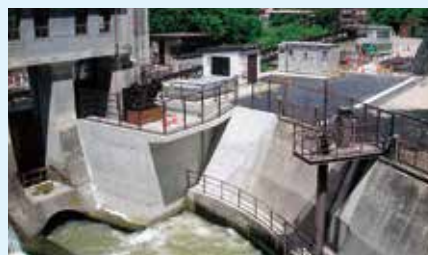
2014年6月に営業運転を開始した飯野発電所(福島県福島市)
