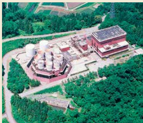
単機として国内最大出力を誇る柳津西山地熱発電所 (最大出力6万5,000kW /福島県柳津町)
