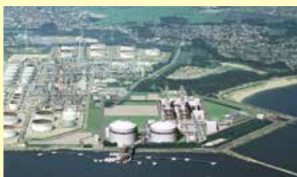
新仙台火力発電所3号系列の完成イメージ (宮城県仙台市)
