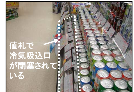
値札による冷気吸込口閉塞
