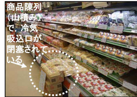
商品陳列(山積み)による 冷気吸込口閉塞
