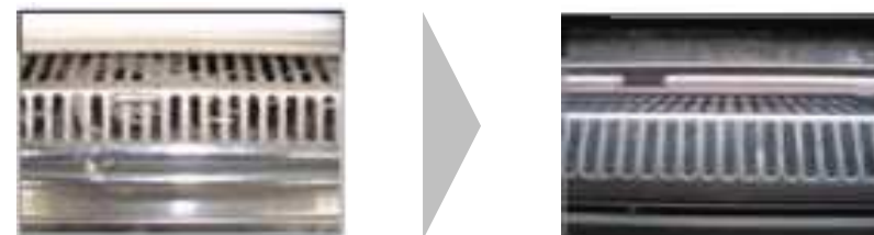
吸込口洗浄前後の状況
