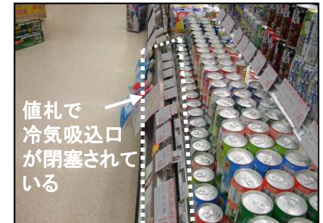
値札による冷気吸込口閉塞
