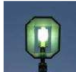
駐車場照明例
