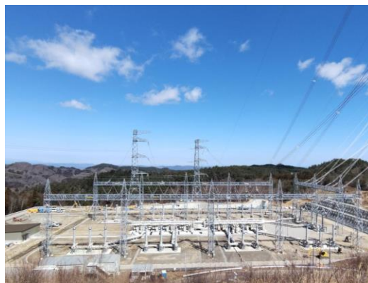
宮城丸森開閉所(50万ボルト) 新設工事の設置状況
