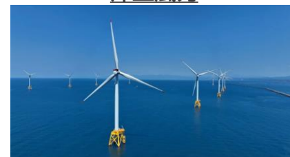
石狩湾新港洋上風力発電事業 (写真提供: JERA)
