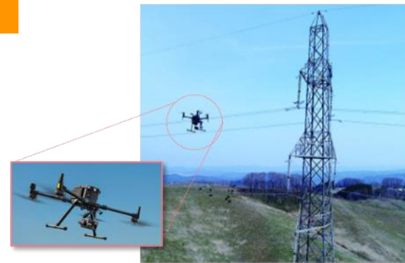
ドローン活用による設備点検の例 (電線劣化状況の確認)
