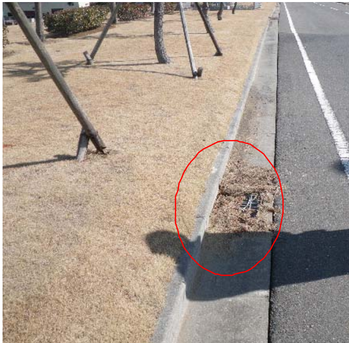
写真A 構内道路上に残留した塵芥
