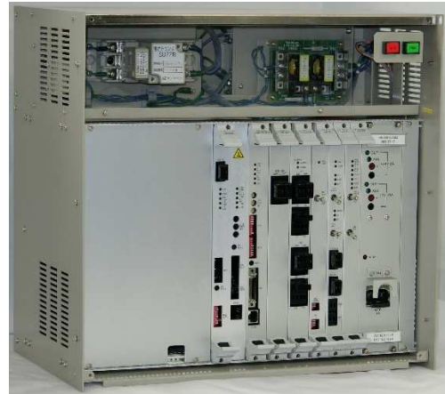
図1 高性能型送電線用デジタル電力線搬送装置
