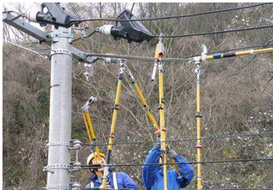
耐張碍子取替工事の様子
