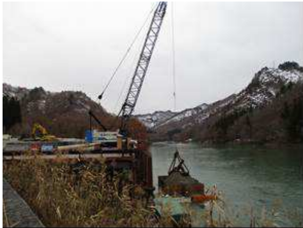
写真1 浚渫土砂搬出状況
