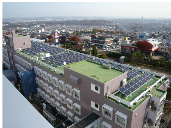
写真1 太陽光パネル設置状況
