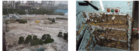
図1 津波襲来直後と配電盤被災状況 2)
