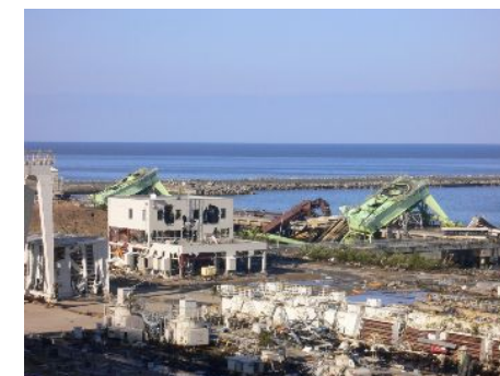
【倒壊した揚炭機】
